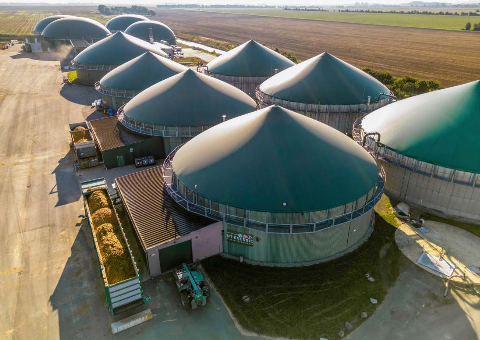
Die Biogasanlage der GraNottGas GmbH hat eine elektrische Leistung von 4,5 MW. Im Einsatz sind sehr viele Co-Substrate – neben Stroh u. a. auch Mist, Hühnertrockenkot und Gülle.
