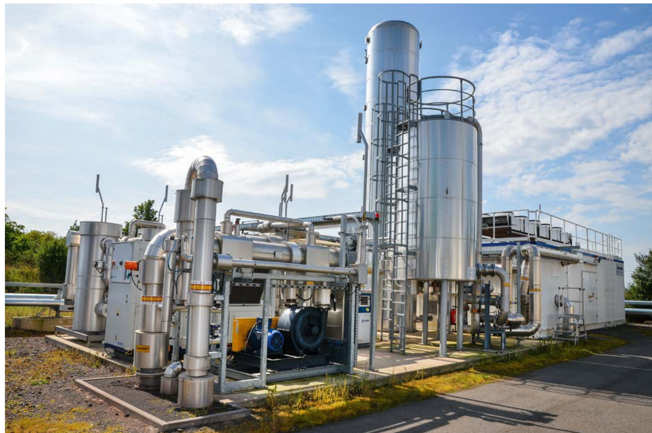
Die Gasaufbereitung basiert auf dem System der drucklosen Aminwäsche.
